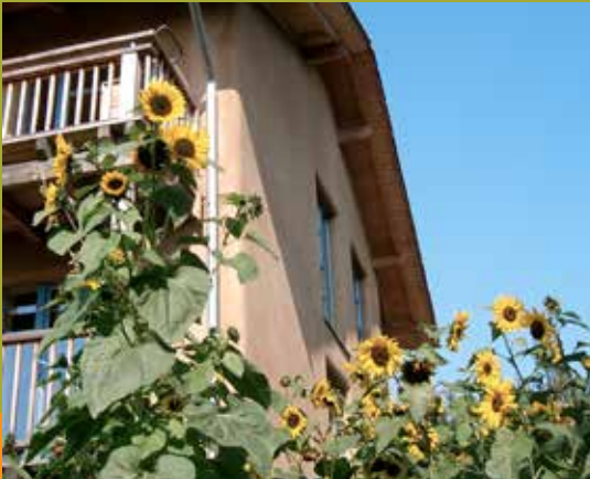
3-geschossiges, direktlehmvorputztes Strohballenhaus
