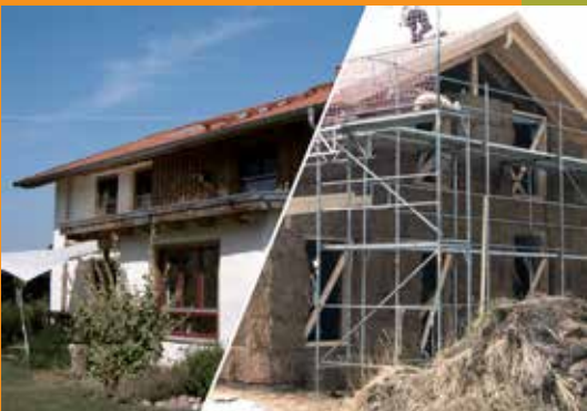
1,5-geschossiges Strohballenhaus, kalkverputzt und holzverkleidet
