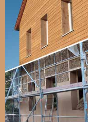
2-geschossiges Strohballenhaus mit eingestehendem Bohlenständerwerk und Plattenbekleidung/ Holzverschalung
