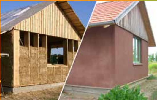
1-geschossiges Strohballenhaus mit engstehendem Bohlenständerwerk
