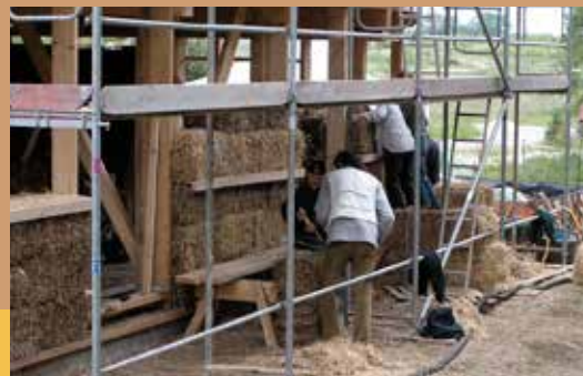
Einbau der Strohballen in weitstehendes Ständerwerk
