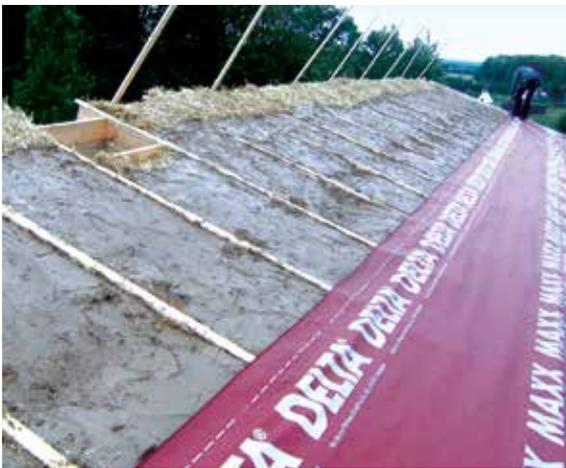
5. Dachstrohballe mit Lehmputzlage und Unterspannbahn.
