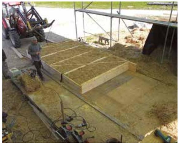
14. Fertiges Wandteil. Herstellungsdauer ca. 4 Stunden.
