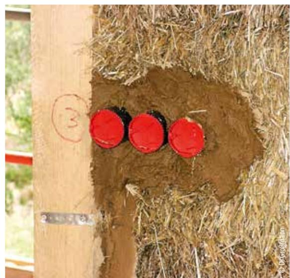
*Im Lehmbett in die Strohdämmung eingelassene Elektroinstallationen*
