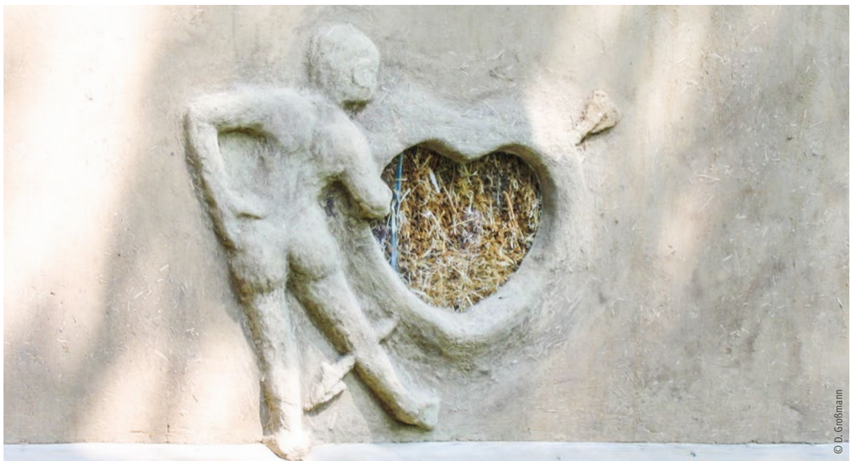
Ein sogenanntes „Truth Window“ zeigt die Strohdämmung
