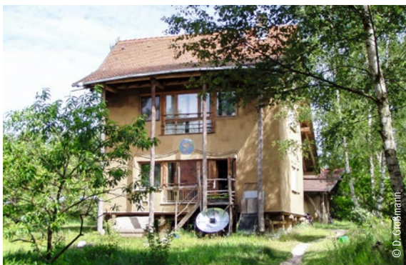
Villa Strohbunt (Sieben Linden): Handbaustelle – errichtet ohne Strom 2001–2003
