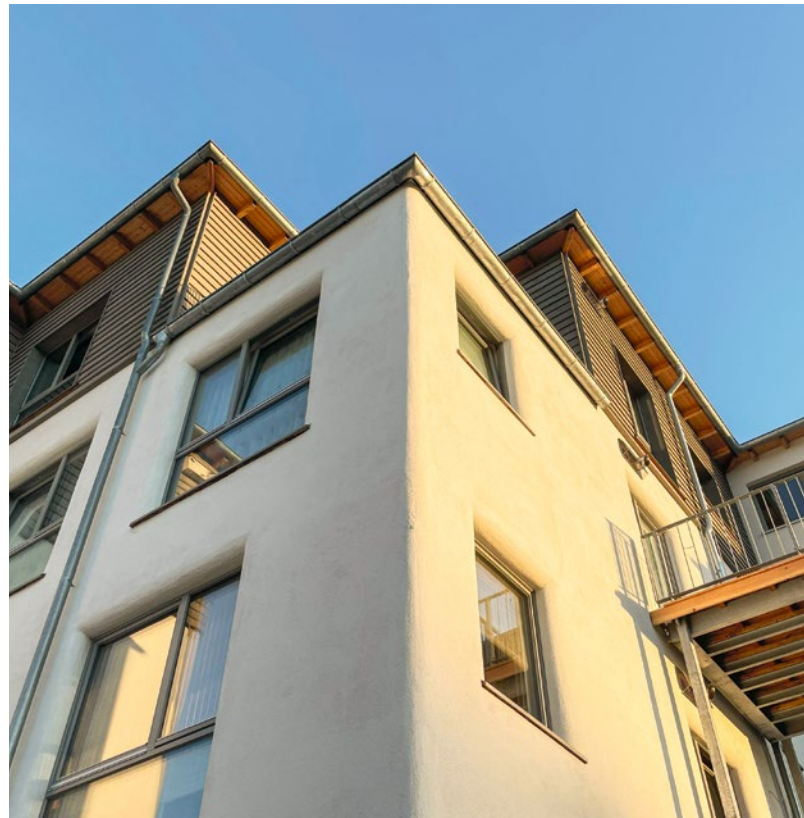
Fassadenecke eines fertiggestellten Strohballenbaus in Froschperspektive
