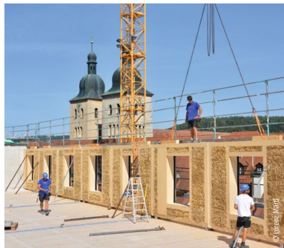
Strohgedämmte Wandelemente beim Richten
