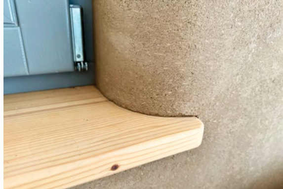
Fensterlaibung mit gerundetem Putz, Innenseite
