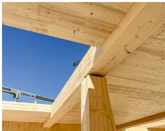
Holzkonstruktion: Tragende Konstruktion aus Brettschichtholzern und Brettsperrholztafeln
