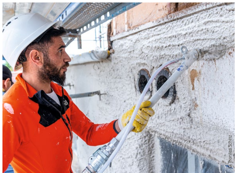
Direkte Verputzung eines Strohballenbaus mit Putzmaschine – innenseitig mit Lehmputz, außenseitig mit Kalkputz
