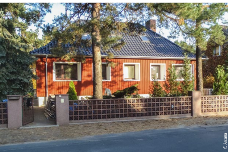
Außen mit Stroh gedämmtes Bestandsgebäude
