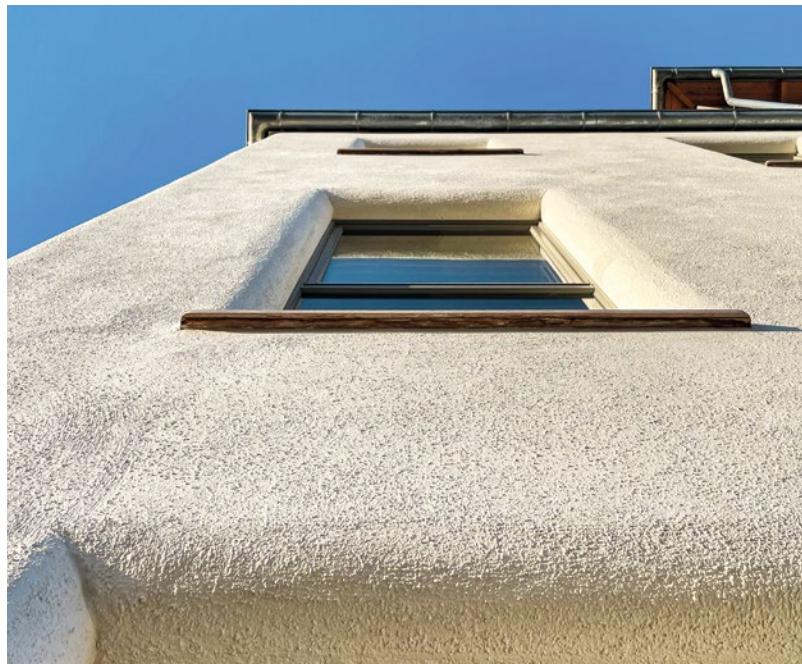
Fassade eines mit Kalk verputzten Strohballebaus
