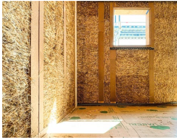
Strohausfachung auf der Baustelle
